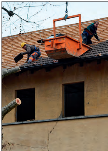
Die alten Gebäude auf dem Vierherrenplatz werden gegenwärtig abgebrochen..
