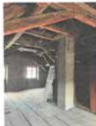
DG: Dachstock (nicht ausgebaut)
